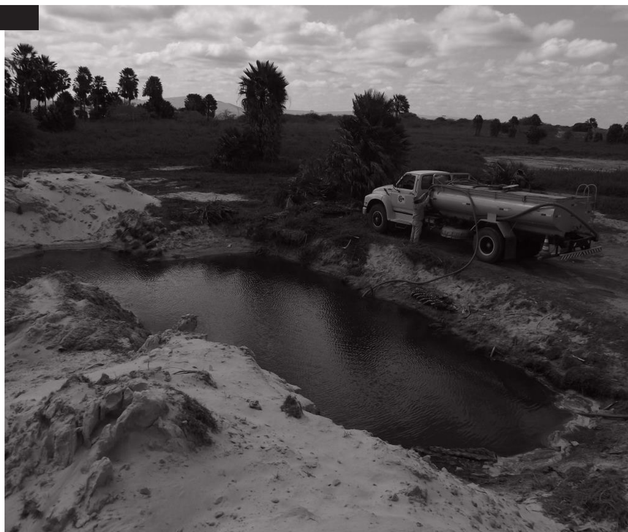
Esgotamento da lagoa do Carnaubal na RDS Ponta do Tubarão para compactação da estrada do parque eólico. Foto: : Tiago Ezequiel da Silva
