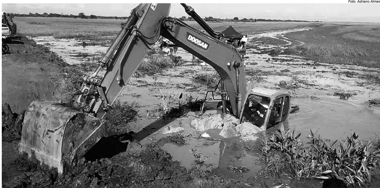
Trator escava para construção dos Linhões de Energia nos Campos Naturais de Santa Rita (MA)
