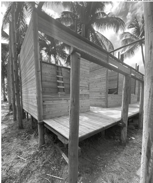
Reconstrução dos ranchos de pesca em Porto de Pedras (AL)
